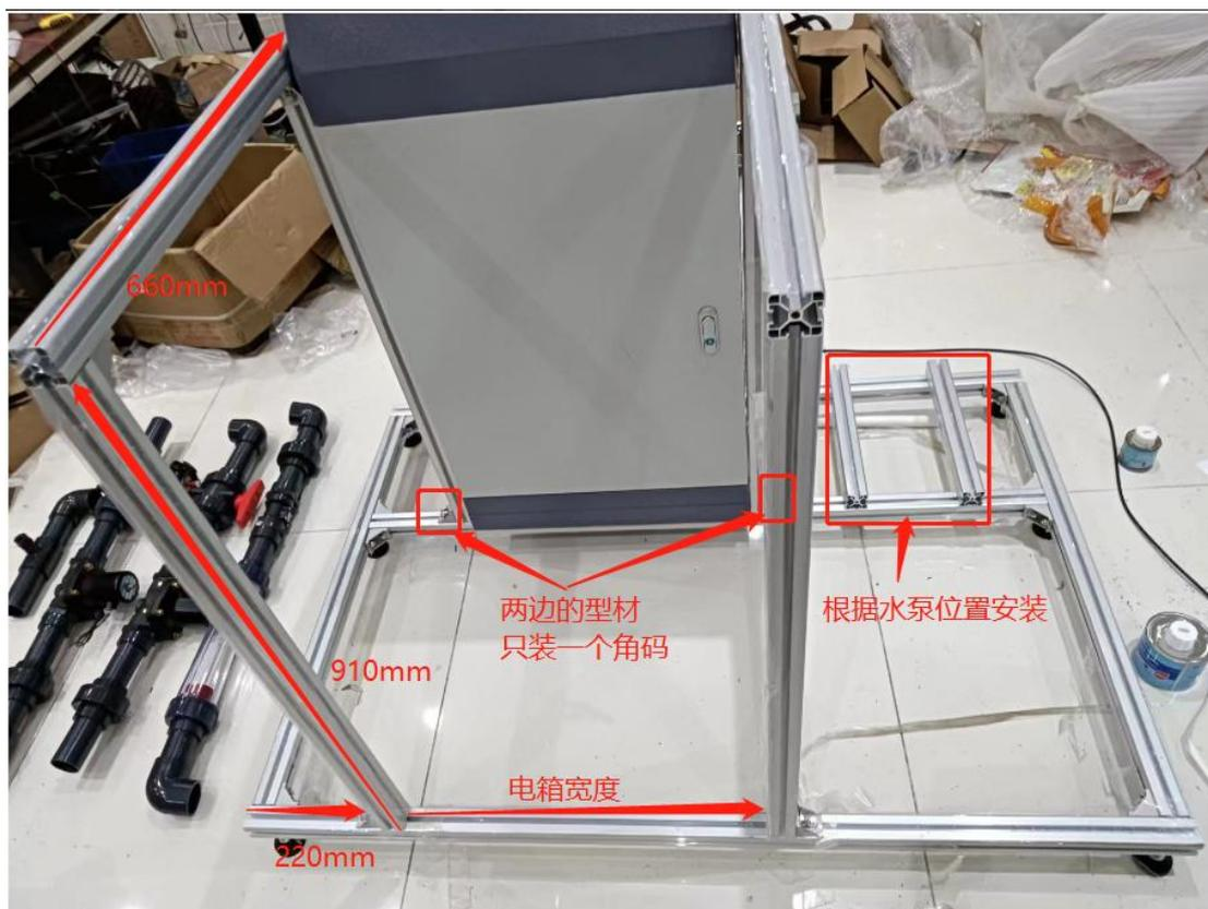
3、先装好两个立架，按照尺寸固定好一边放入电箱再装好另一边立架
